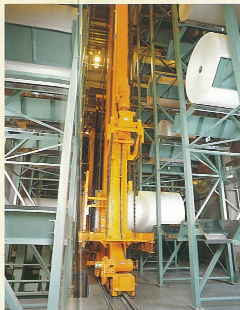
出庫中のスタッククレーン Stacker crane performing removal from storage
