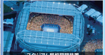
スタジアム屋根開閉装置 スチールケーブルベヤシステム
