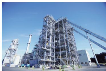
バイオマス発電所向けバケットエレベータ(2016年)
